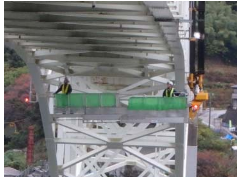
橋梁点検車での調査
