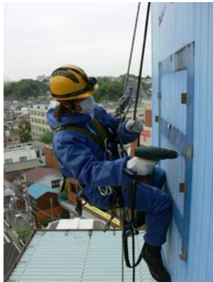
ビル看板撤去
