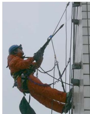
構造物高所 高圧洗浄
