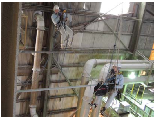
製造工場内天井 吊足場設置
