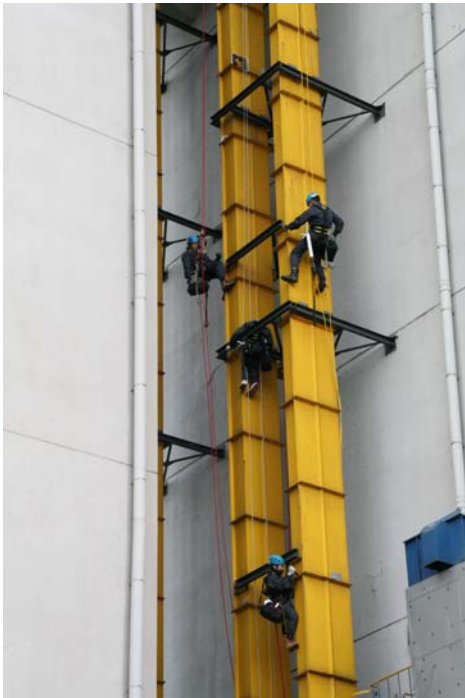
バケットコンベア点検補修
