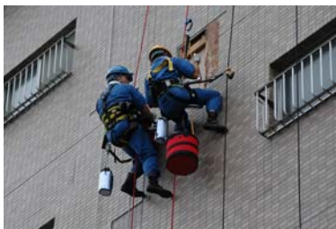
ビル外壁補修
