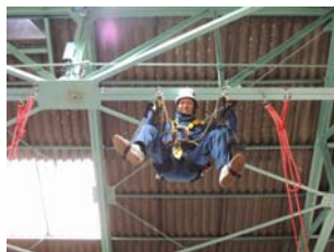
固定ボルトの水平エイドクライミング
