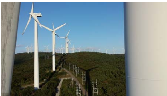
青森 尻屋 風力発電ブレード補修
