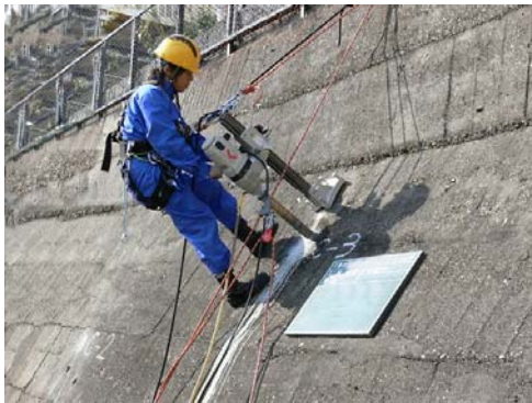
法面コア抜き調査
