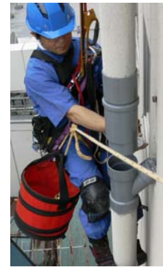
配管設備 変更工事
